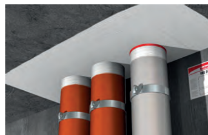
Przejścia instalacyjne przez strop
