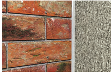
Wypełnienie spoiny na złączu ściany ze ścianą
