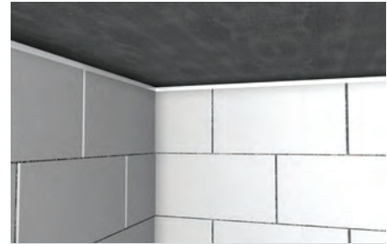
Wypełnienie złącza ściany ze stropem
