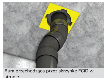
Montaż skrzynki FCID w stropie żelbetowym
